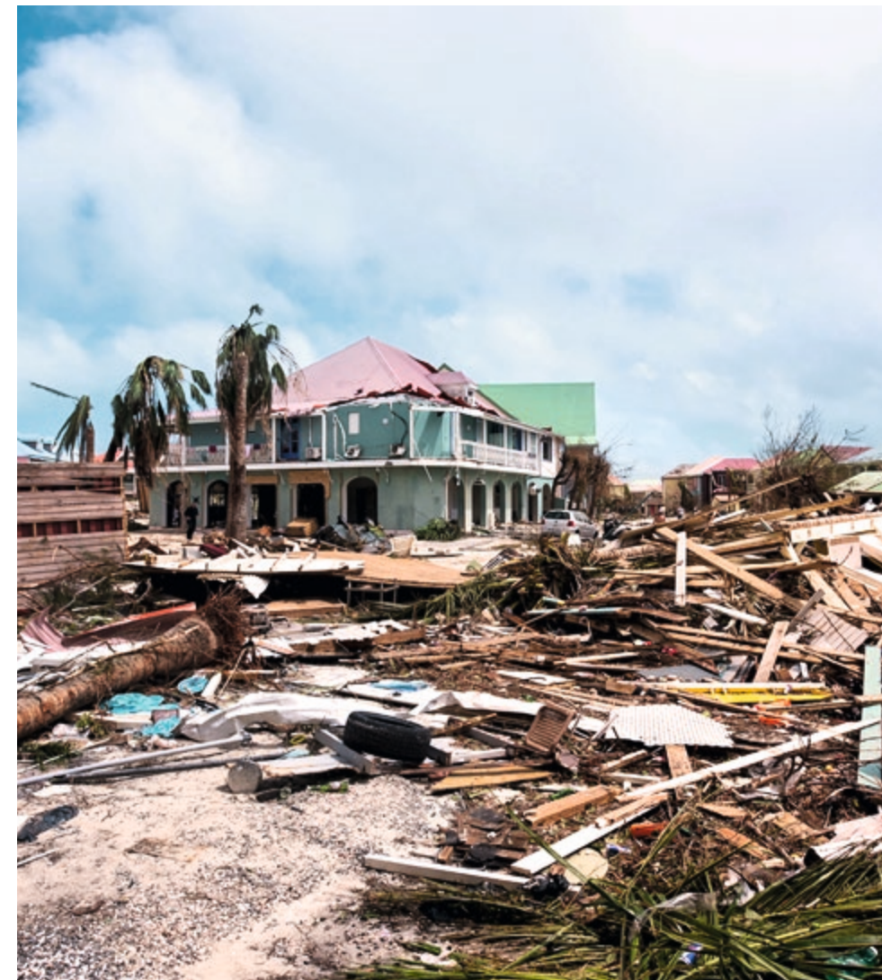
Maison détruite par l'ouragan Irma à Saint-Martin.
